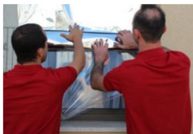
**Étape 8 alternative** - Les deux poseurs placent le film sur la vitre avec le côté adhésif humide sur le verre. Tandis que l'un des poseurs soutient le film enroulé, l'autre tire le support dorsal anti-adhésif vers le bas.
