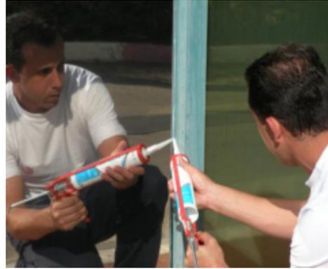
**Étape 14 - Étanchéité des bords** : Laissez le film sécher pendant 24 heures, puis dans les 72 heures, terminez par l'étanchéité des bords sur les quatre bords.
