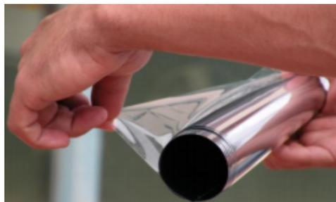
**Étape 3 - Prédécoupe du film :** Découpez le film à la taille de la fenêtre en laissant un bord de chevauchement de 2 cm tout autour : préparez le film directement depuis la boîte en découpant du côté du revêtement dur avec une lame OLFA®. Assurez-vous que le film est enroulé avec le support dorsal anti-adhésive à l'extérieur (revêtement SR à l'intérieur).
