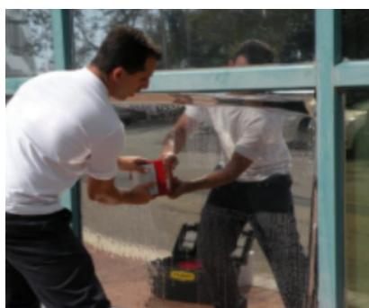
**Étape 9** - En utilisant une raclette très résistante pour films de sécurité de 15 cm, raclez le film en partant du centre avec des mouvements fermes vers le bas et vers l'extérieur, et éliminez l'eau et les bulles d'air emprisonnées entre le film et la vitre.
